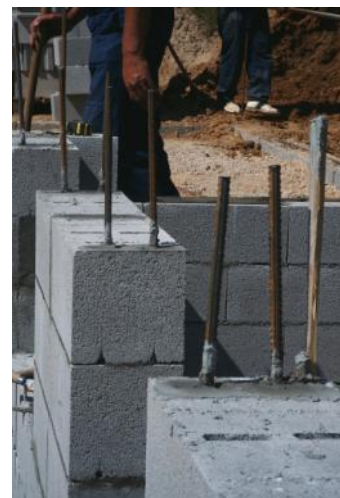
Obr. 1 - detail konštrukcie rohu stavby
